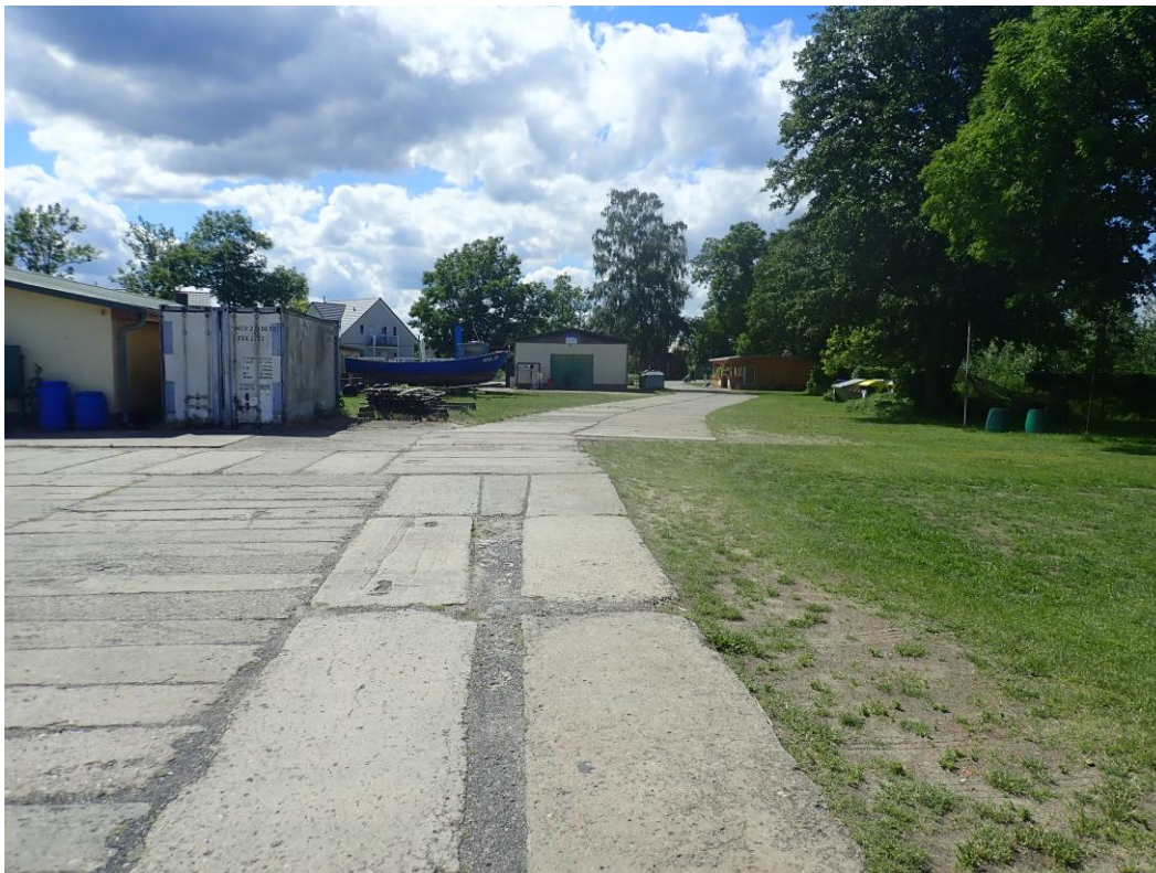
Bild 17: versiegelter Weg unterhalb des Caravan-Stellplatzes in Richtung Hauptstraße
