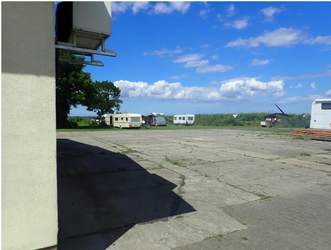
Bild 16: versiegelte Freifläche östlich der Bootshäuser
